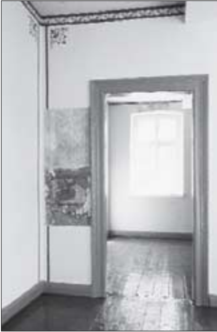
Zeche Hannover in Bochum-Hordel. Nach Befund wiederhergestellte Farbgebung der Arbeiterhäuser Am Rübenkamp von 1892.
